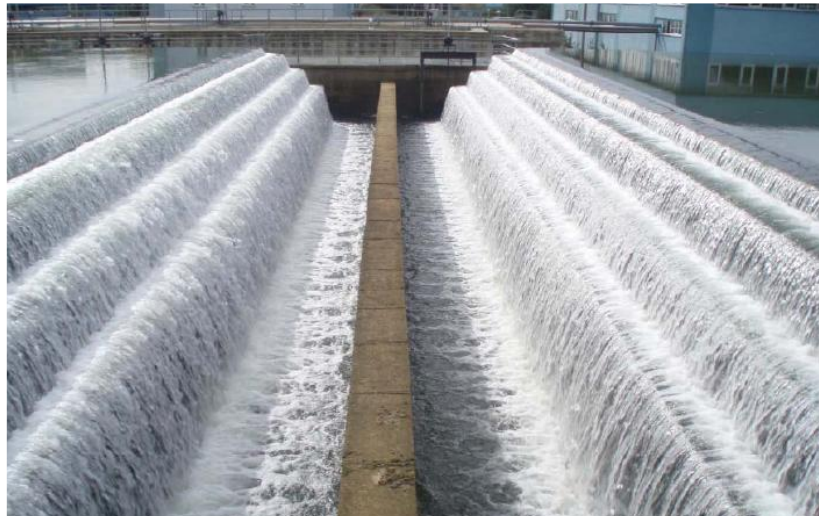
شکل ۱۳- استفاده از برج های آبشاری در هوادهی آب
