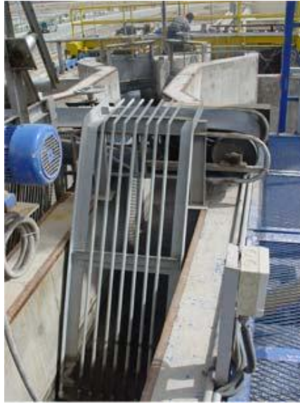
شکل ۲۱- واحد آشغال گیری با پاکسازی دستی
