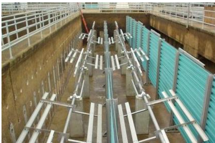
شکل ۳۱- انواع مختلف همزن در واحد اختلاط سریع و لخته سازی
