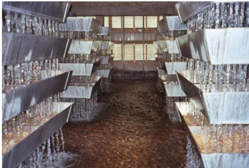
شکل ۱۵- استفاده از برج های سینی دار در هوادهی آب
